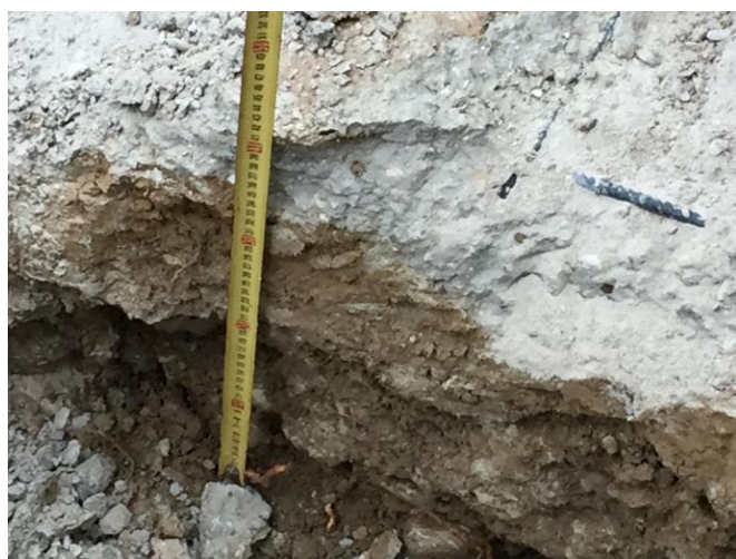
Figura 14 - Armature cordolo di fondazione
