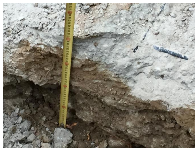
Figura 15 - Armature cordolo di fondazione
